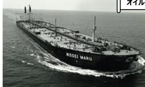
げんゆを運ぶ船で、積みおろしには、ポンプやパイプラインを使います。写真は、呉で造られた石油タンカー「日精丸」です。呉では、こうしたオイルタンカーを含む大型の船がたくさん造られています。
